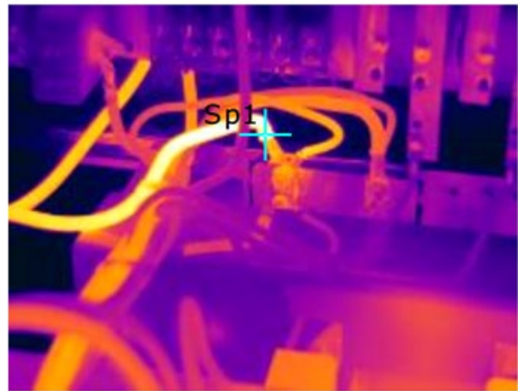
Exemple d'analyse grâce à la thermographie infrarouge réalisée sur un onduleur classé
