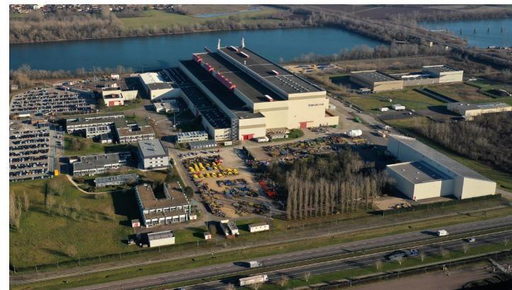
L'usine de Saint-Marcel est dédiée depuis 1975 à la fabrication des composants lourds du circuit primaire : la cuve et le couvercle du réacteur, les générateurs de vapeur, le pressuriseur et les ensembles de tuyauteries du circuit primaire. L'usine dispose de plus de **40 000 m<sup>2</sup> d'ateliers**. Depuis sa mise en service, l'usine a livré **693 composants** pour **106 réacteurs** dans **11 pays**.
