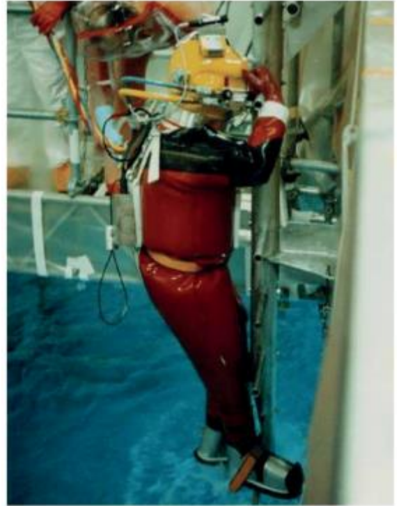
乏燃料池内潜水员在进行人工施工
