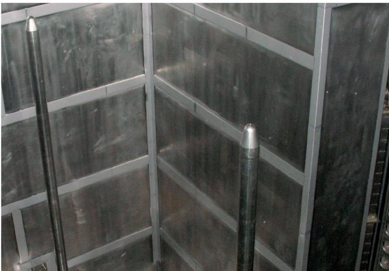
堆腔维修: 全部焊接接头均涂覆一层本粘合剂, 作为预防性措施
