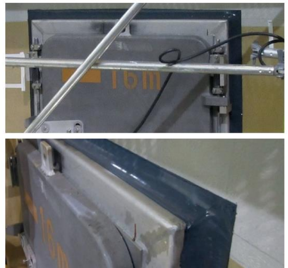
在涂有环氧树脂漆的堆腔内对墙壁穿孔进行密封
