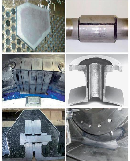
维修举例: 管板, 卡夹, 衬里, 接管, 法兰和伸缩缝
