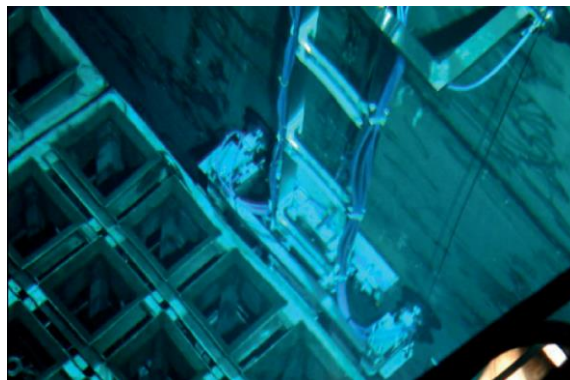
应用机械手技术进行远程维修施工
