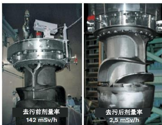
去污前后的反应堆冷却剂泵
