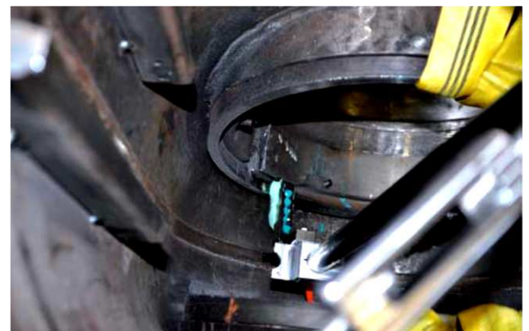
Untersuchung einer mit herkömmlichen Methoden nicht zugänglichen Armatur
