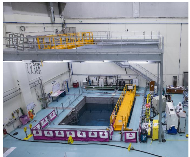
Piscine chaude en zone contrôlée © Framatome
