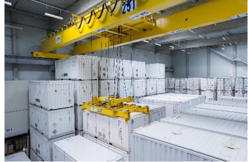
Surface d'entreposage des conteneurs en zone contrôlée © Framatome
